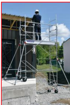
Installation en dénivelé intégrée
