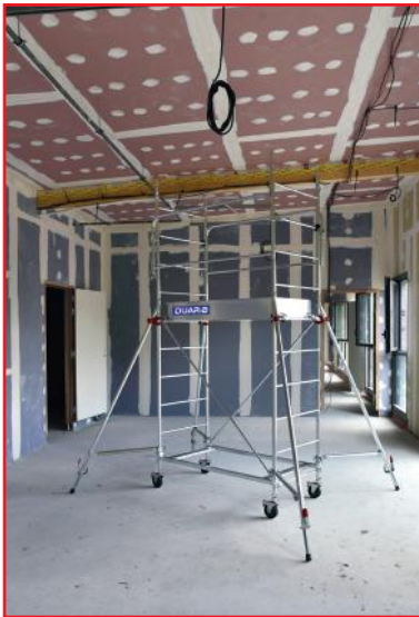
Passage dans les portes de 0,83 m.
